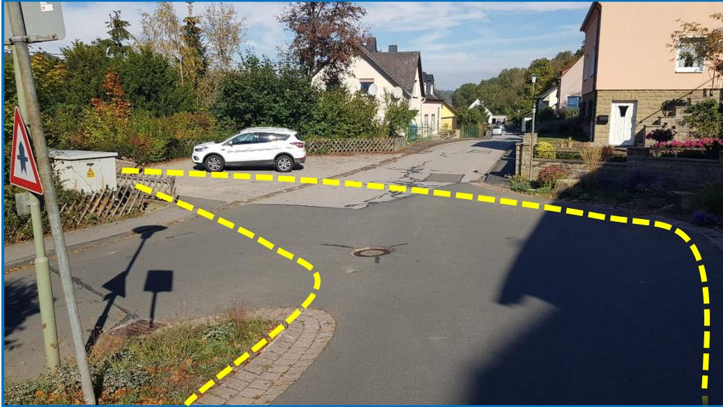
**Abbildung 13: Umbau Einmündung: Absenken im Fließbereich, Anheben in den Seitenbereichen (Quelle: Ingenieurbüro HYDRODAT)**
