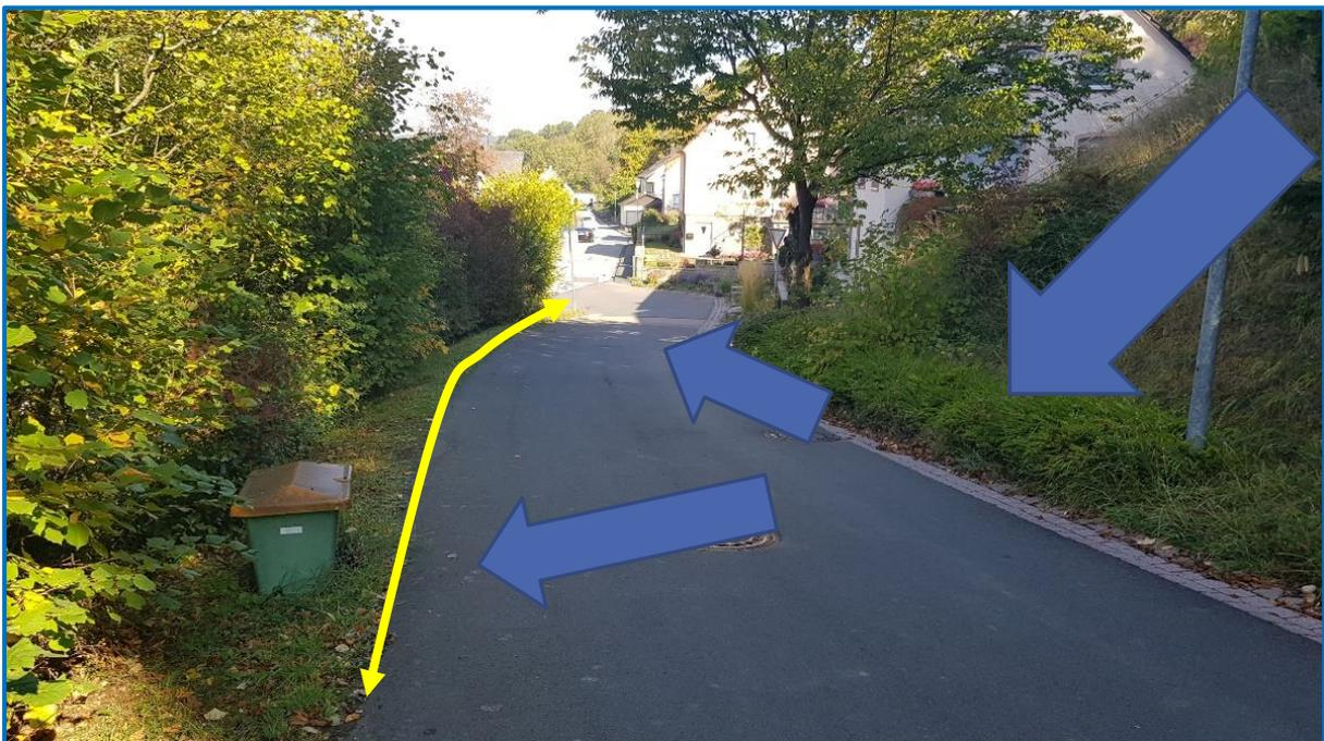
Abbildung 12: Die schräg zum Hang verlaufende Straße wird aufgrund ihrer Querneigung zwar das rechts vom Hang zulaufende Wasser umlenken; um das auch bei höheren Zuflüssen zu erreichen, sollen hier Hochborde (gelber Pfeil) eingebaut werden. (Quelle: Ingenieurbüro HYDRODAT)
