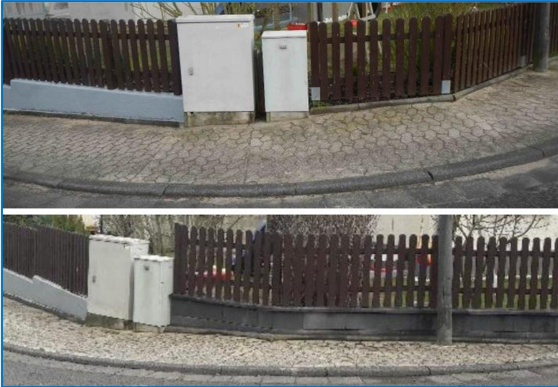
Abbildung 11: Vorher – nachher, Einbau einer Palisade zur Wasserlenkung (Ingenieurbüro FRANZ FISCHER)
